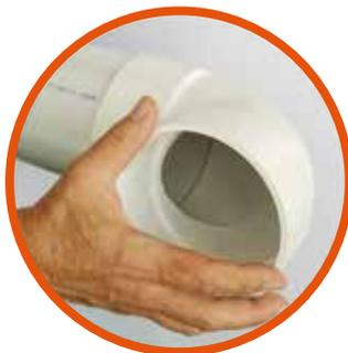
Una el tubo con el accesorio asegurándose de un buen asentamiento y dele un cuarto de vuelta para distribuir el Cemento PVC, mantenga firmemente la unión por 30 segundos.
